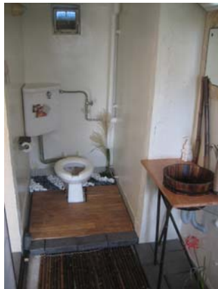
トイレ+洗面所
